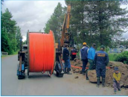
Valokuituputkea asennetaan maahan. Kuva: Nina Plogman.
